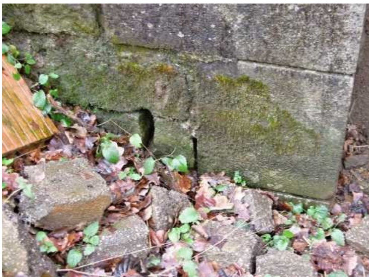
Dřík opěry 2, levý bok, volné spáry v patě opěry.
