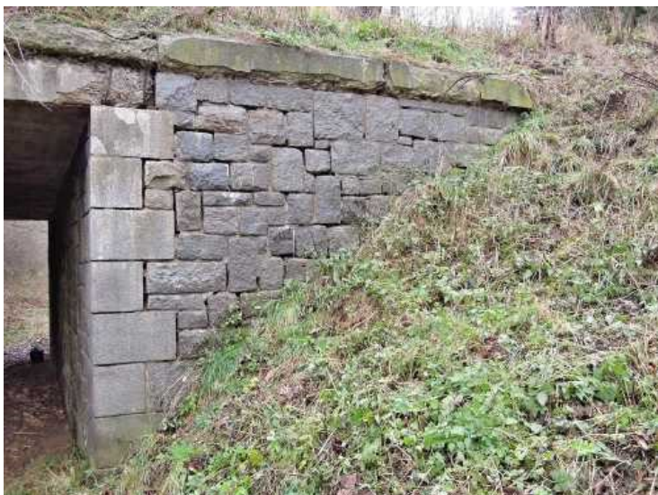
Pohled na pravé křídlo opěry 2, vyplavené spárování zdiva křídla.
