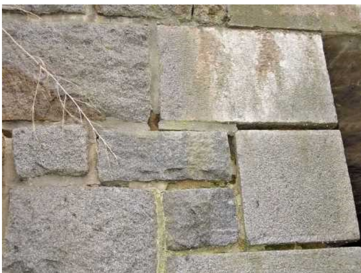
Dtto, detail stavu spárování ve zdivu.
