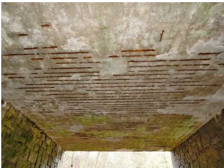
Podhled NK, levá strana, odpadlá krycí vrstva betonu nedostatečné tloušťky od hlavní podélné výztuže desky, zatékání v ploše konstrukce.
