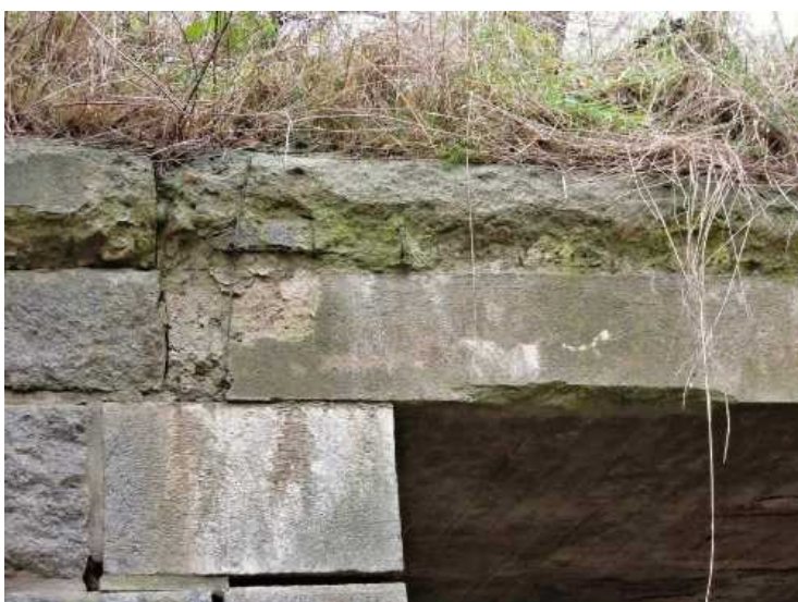
Opěra 1, pravý líc, zatékání dilatační spárou, hloubková degradace betonu boku NK a římsy, volné spáry zdiva opěry.
