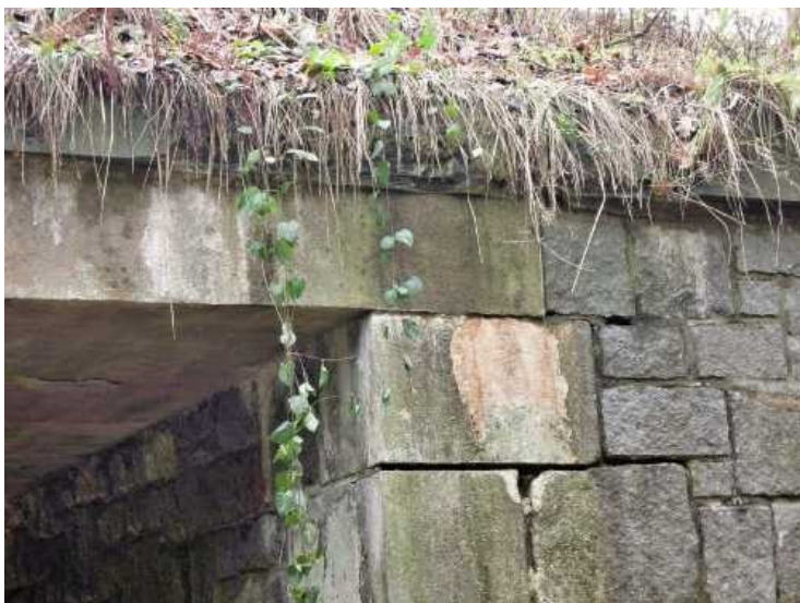
Opěra 1, levý bok, stopy po průsacích z úložné spáry, zatékání pod římsou, volné spáry zdiva.
