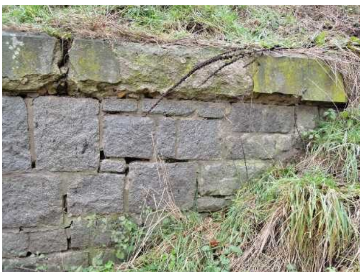
Dtto, detail poškození a rozpadu betonu římsy, hloubkově vyplavené spárování.
