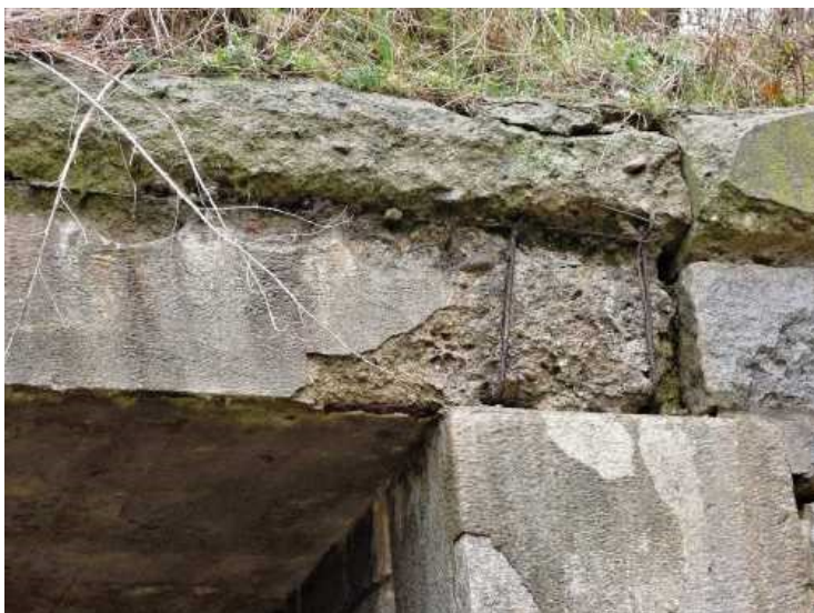
Uložení konstrukce na opěře 2, pravý bok, zatékání dilatační spárou, hloubkový rozpad betonu NK v uložení, obnažená výztuž, rozpad betonu římsy.
