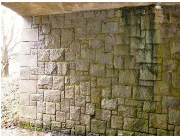
Opěra 1, pravá část, zatékání a mikroorganismy pod úložnou spárou po celé výšce opěry.
